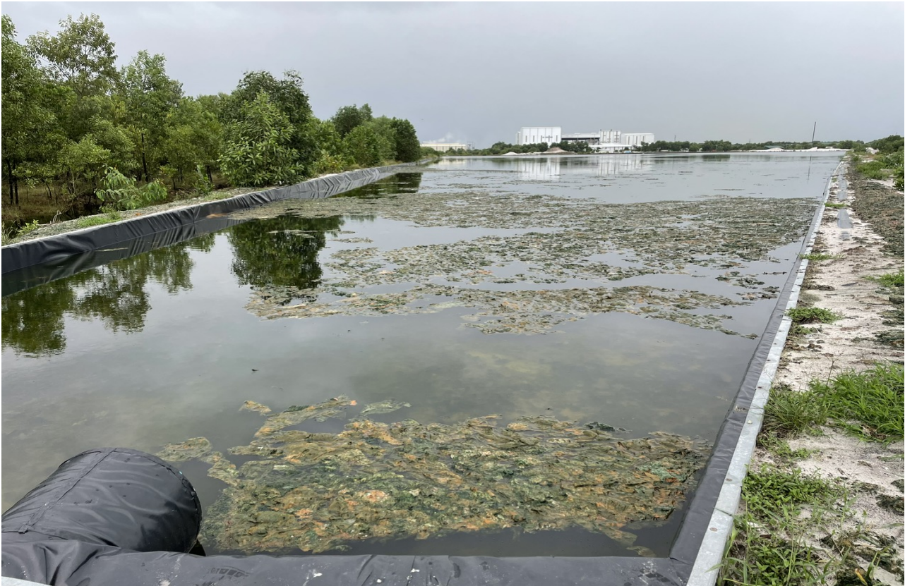
Hình ảnh ghi nhận tại hiện trường khu vực sân phơi nước thải dự án Hệ thống xử lý nước thải tuần hoàn mở rộng của Nhà máy Kanglongda (Kèm theo Công văn số ... /KKTCN-TNMT ngày ... /9/2024 của BQL KKT, CN tỉnh)
